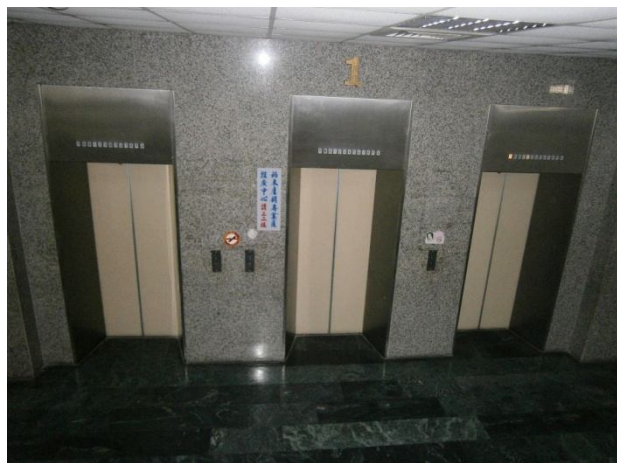
辦公大樓前三部電梯
